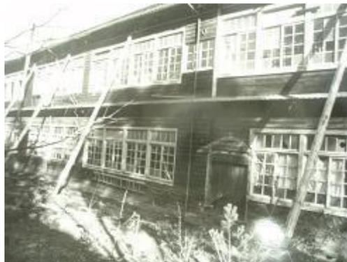
松代群発地震では有感地震が6万回超(震度5が9回、4が48回、3が413回)。最大はM5.4で震度は5。校舎は古い木造でしたから、倒壊防止に太い丸太で補強しました。(写真は綿内小学校)
